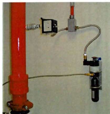
Figura 3.3: Cilindro auxiliar de nitrogênio e pressostato
